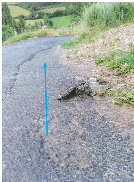
Érosion observée sous la route (2019)
