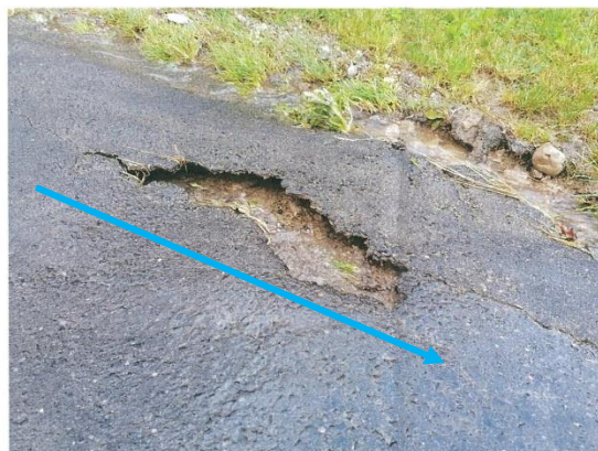
Érosion observée sous la route (2019)
